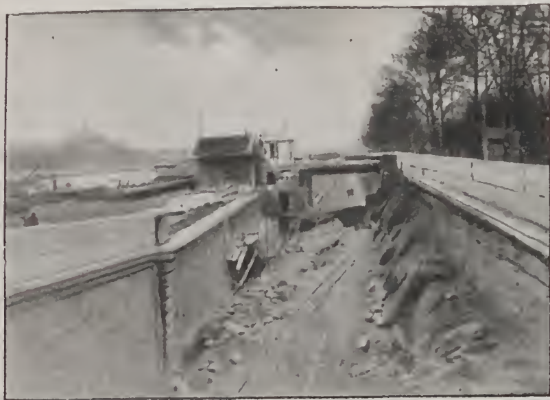
La tranchée avec ses murs de soutènement le long du Jardin des Plantes.
